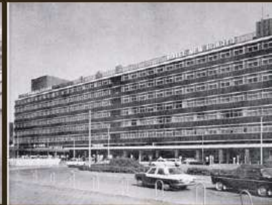
博多ステーションビル 1963年開業の博多駅ビル（3代目）
